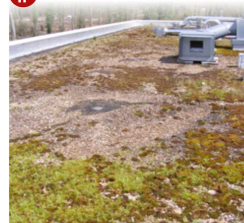
Enlèvement des mousses, lichens et autres éléments indésirables; Traitement hydrofuge
